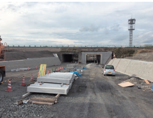
大谷地区スマートインターチェンジの工事現場
