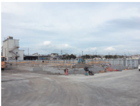
用宗漁港、新荷捌き場の工事現場
