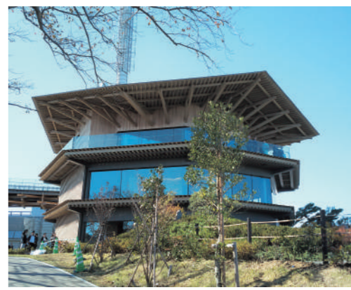
11/2 日本平夢テラス完成式典にて
