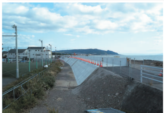
■静岡海岸中島地区の防潮堤
